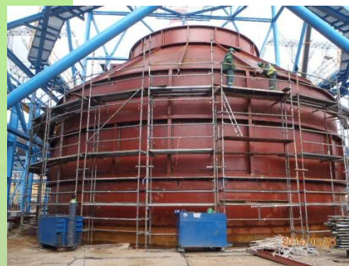
吸収塔シェル据付 Absorber Shell Prefabrication
