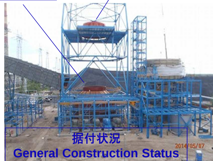
吸収塔シェル据付 Absorber Shell Prefabrication
